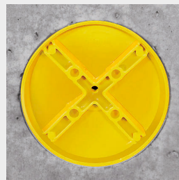
ochranné víčko po odstranění bednění
