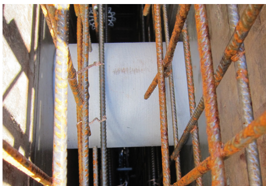
Pažnice HRD-FU upevněná v bedněti
