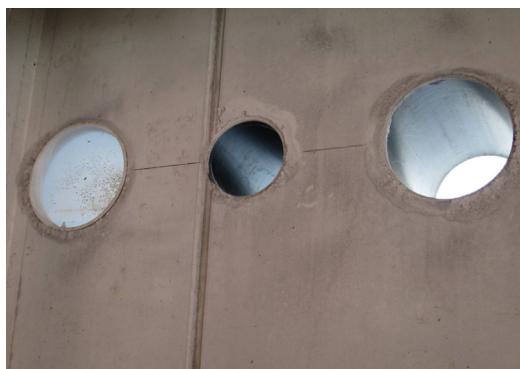
Pažnice HRD-FU po betonáži
