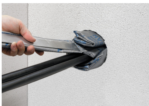
Protipožární pytle HVS v jádrovém vrtání
