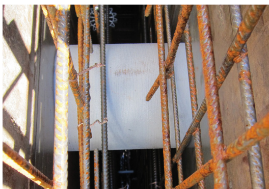
Pažnice HRD-FU upevněná v bednění
