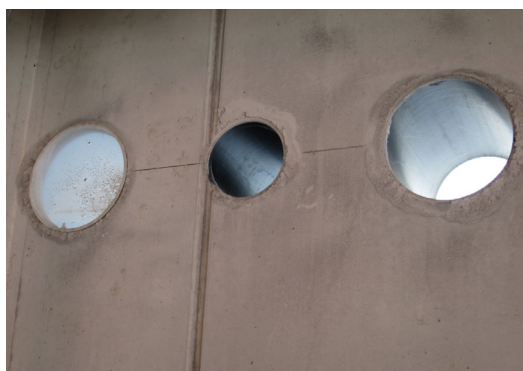
Pažnice HRD-FU po betonáži
